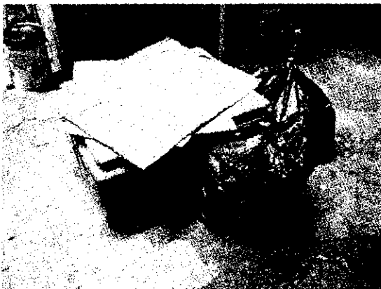
Foto 06. Cisterna de Agua con tapa que no brinda garantía de hermeticidad, y al costado bolsas con residuos - Sala de Máquinas.
